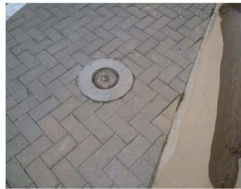
DETALLE DE TAPA DE VALVULAS EN CALLE DE ADQUINES.
