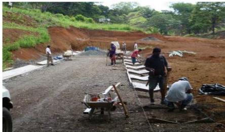
OBRAS EN SERVIDUMBRE N° 7.
